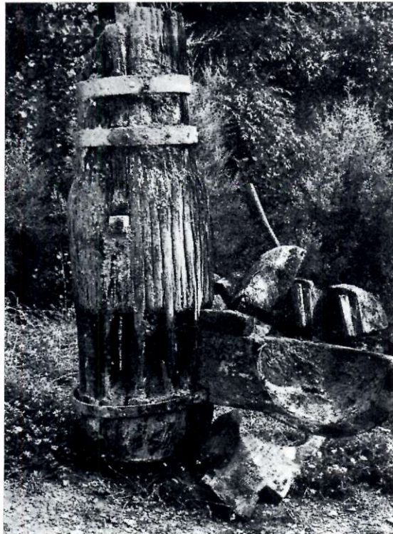
FIG. 7. — Albero motore e pala del mulino di S. Maria in Campolongo. Si noti nella parte superiore il sistema di alloggiamento dello spadone.
